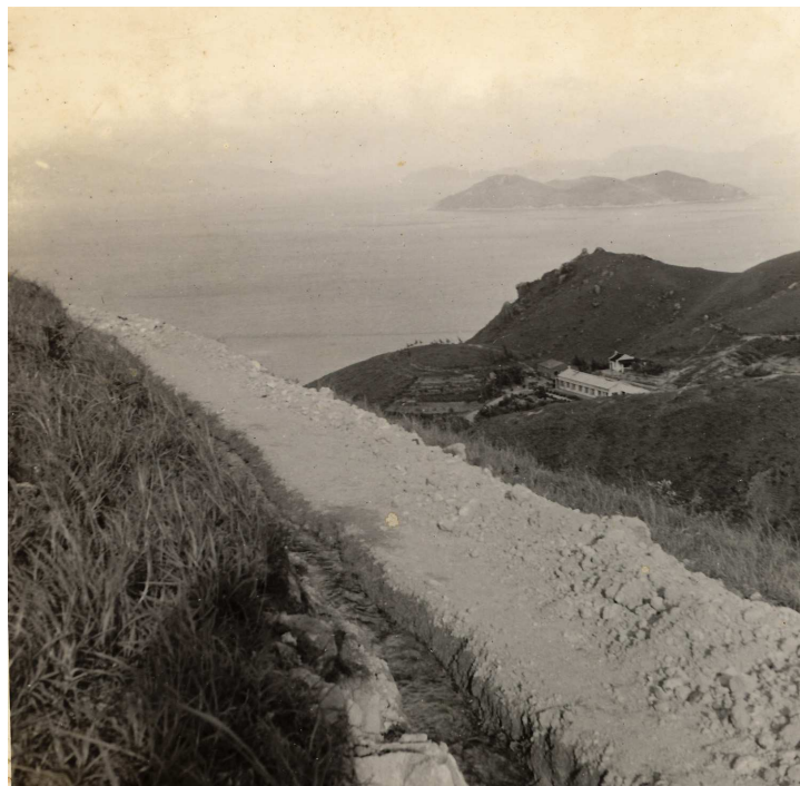
圖片(12) ：小路旁邊的溝道是早期用來引水的，現在已以水管代替。
