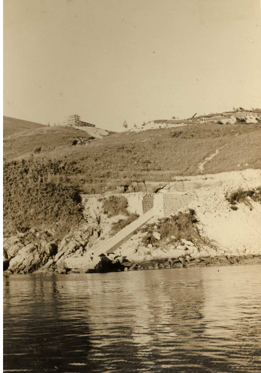
圖片(7)：這個舊碼頭，因為太過傾斜，已棄置不用。 The old pier is too steep to be of any use now.
