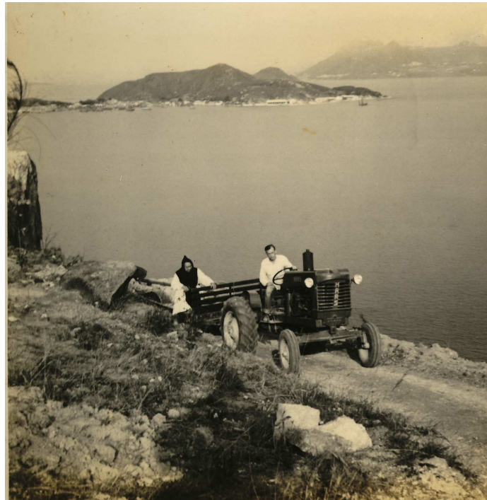
圖片(24)：替道路鋪上三合土 (1967 年)。 The applying of cement to the road in 1967.
